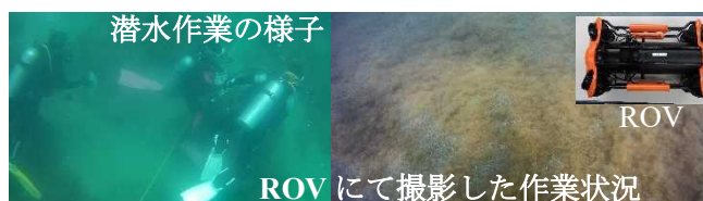
写真-4 潜水作業状況(左)・海底状況とROV(右)
